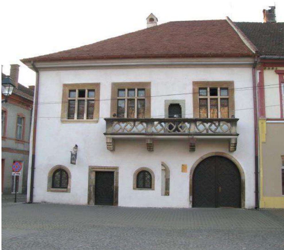
Fig. 2.5 CASA BEUCHEL cunoscuta sub numele CASA ION ZIDARU, MUNICIPIUL BISTRIȚA
